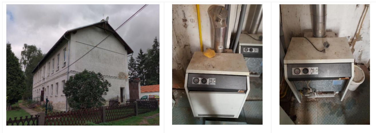
Obrázek 7 Objekt bývalé školky (azylový dům) – exteriér a plynové kotle
