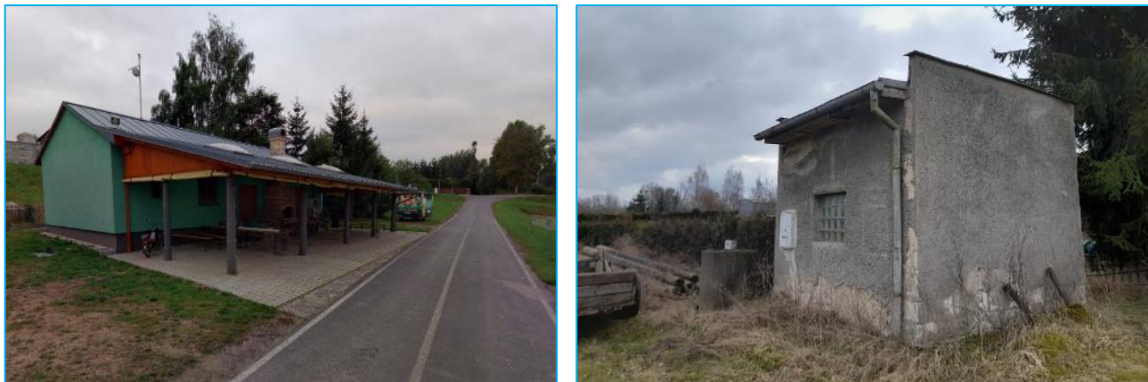
Obrázek 2 Budovy fotbalových kabin a přilehlý objekt vodárny
